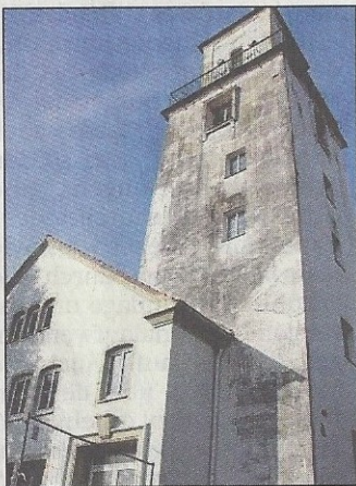
Der alte Kirchturm an der Worthstraße wird bald abgerissen.
